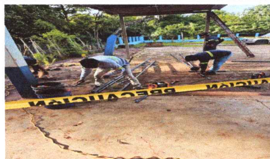
foto 6 mantenimiento de cancha en columnas metalicas tipo joist
