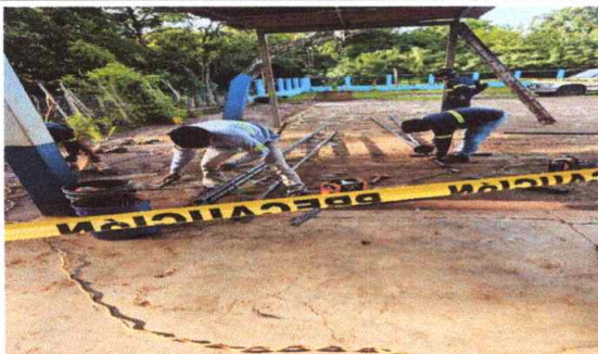
foto 5 mantenimiento de cancha, cimentaciones, pilotes y pedestales
