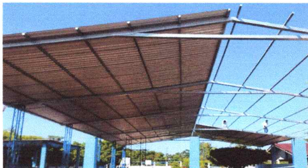
foto 1 sustitucion de lamina por lamina troquelada calibre 26
