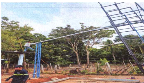
foto 3 sustitucion de estructura de soporte metal por metal
