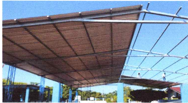
foto 2 sustitucion de lamina por lamina troquelada calibre 26
