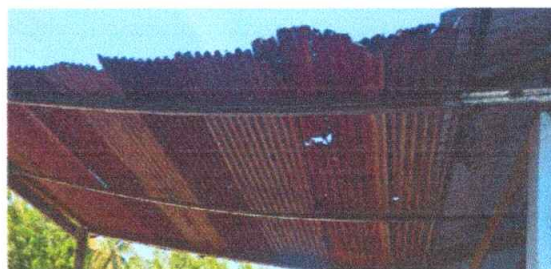
Mantenimiento de cancha en columnas metálicas tipo Joist
