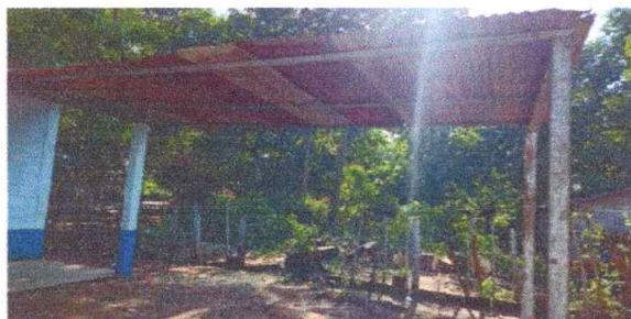
Sustitución de estructura de soporte metal por metal
