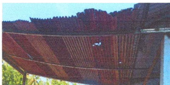
Sustitución de lámina por lámina troquelada calibre 26
