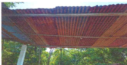
Mantenimiento de cancha, cimentaciones, pilotes y pedestales.
