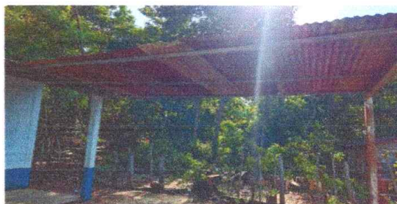
Sustitución de estructura de soporte metal por metal
