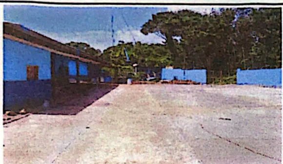
Foto No. 03 Sustitución de 380 metros cuadrados de piso de torta de concreto
