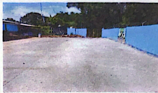
Foto No. 02 Sustitución de 380 metros cuadrados de piso de torta de concreto
