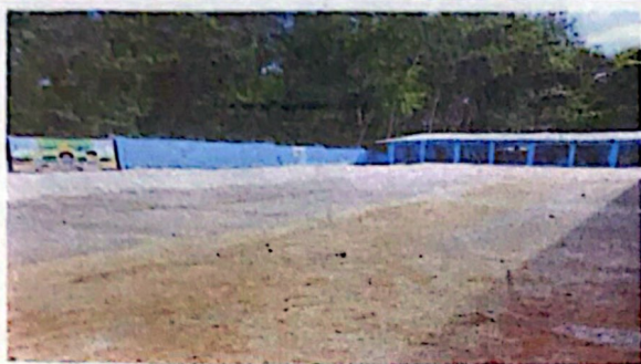
Foto No. 01 Sustitución de 380 metros cuadrados de piso de torta de concreto
