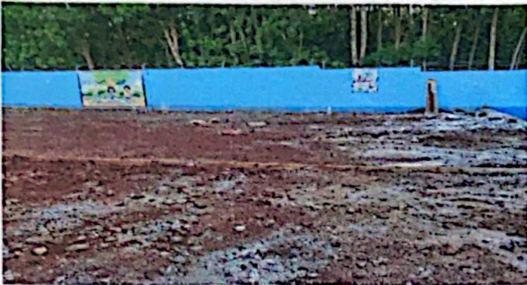
Foto No. 03 Sustitución de 380 metros cuadrados de piso de torta de concreto
