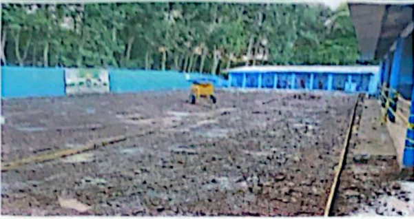
Foto No. 01 Sustitución de 380 metros cuadrados de piso de torta de concreto
