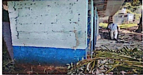
Foto No. 04 Suministro y aplicación de 100 metros cuadrados pintura en muros de sanitarios
