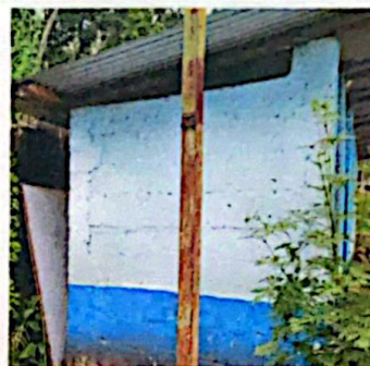
Foto No. 04 Suministro y aplicación de 100 metros cuadrados pintura en muros de sanitarios
