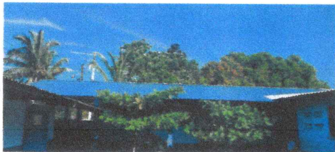
Foto1: SUSTITUCION DE LAMINA, POR LAMINA TROQUELADA CALIBRE 26 125 METROS CUADRADOS
