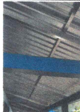
Foto 2: SUSTITUCION DE ESTRUCTURA DE SOPORTE DE MADERA POR METAL 147.5 METROS CUADRADOS
