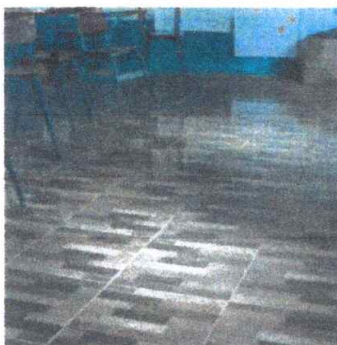
Foto 5: SUSTITUCION DE PISO CERAMICO 245 METROS CUADRADOS
