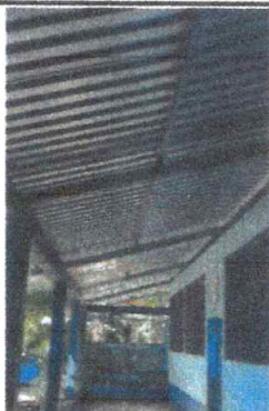
Foto 3: SUSTITUCION DE ESTRUCTURA DE SOPORTE DE MADERA POR METAL 147.5 METROS CUADRADOS
