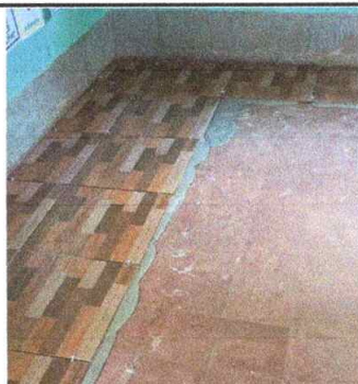
Foto 5: SUSTITUCION DE PISO CERAMICO 245 METROS CUADRADOS
