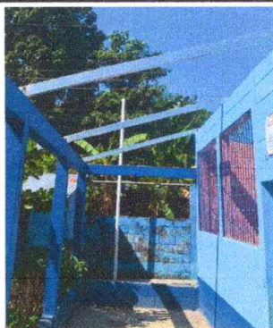
Foto 3: SUSTITUCION DE ESTRUCTURA DE SOPORTE DE MADERA POR METAL 147.5 METROS CUADRADOS
