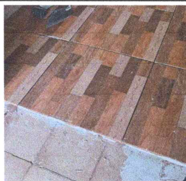
Foto 4: SUSTITUCION DE PISO CERAMICO 245 METROS CUADRADOS
