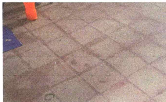
Sustitución de piso por piso cerámico
