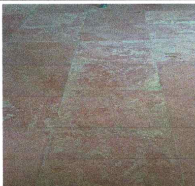
Sustitución de piso por piso cerámico
