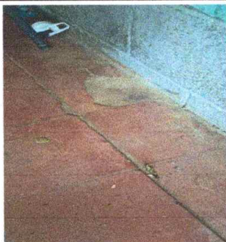
Sustitución de piso por piso cerámico
