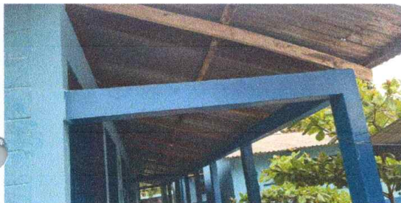
Sustitución de lámina, por lámina troquelada Calibre 26
