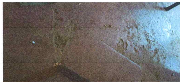
Sustitución de piso por piso cerámico
