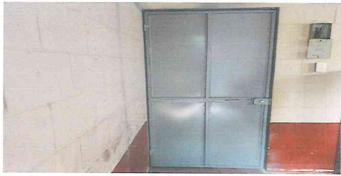
Foto7: Sustitucion de una puerta de barratos por puerta de metal
