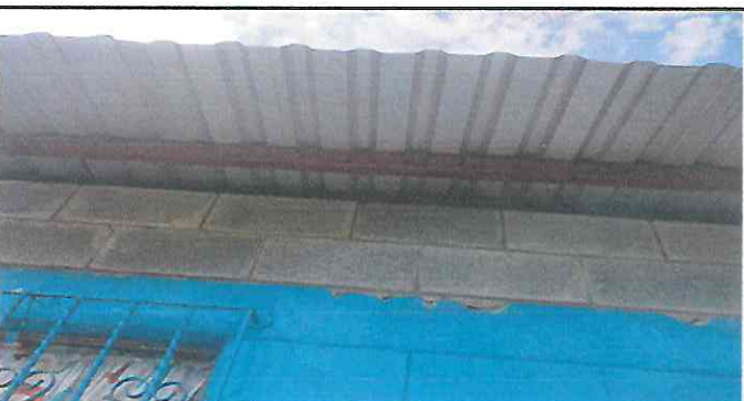
Foto 6: Mantenimiento correctivo de 16 metros cuadrados de muro de block.
