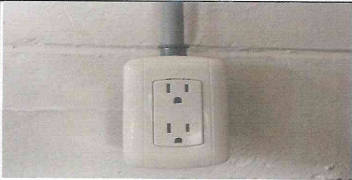
Foto 9: Sustitucion de 9 tomacorrientes dobles
