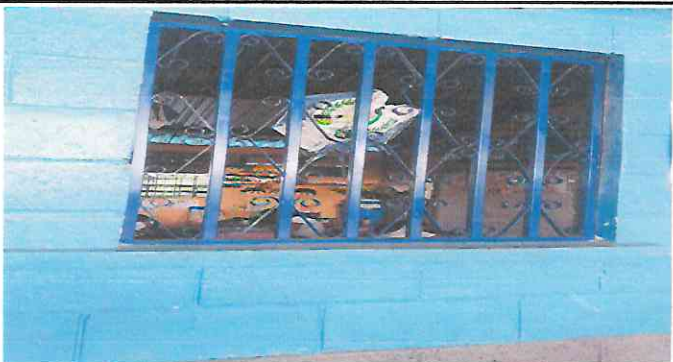
Foto 4: Sustitucion de 11 M2 de balcones de barrotes de hierro por tubo cuadrado de 1".
