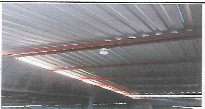
Foto 10: Sustitucion de 12 bombillos LED-GLOBO de 30 watts, 2400 lumenes.
