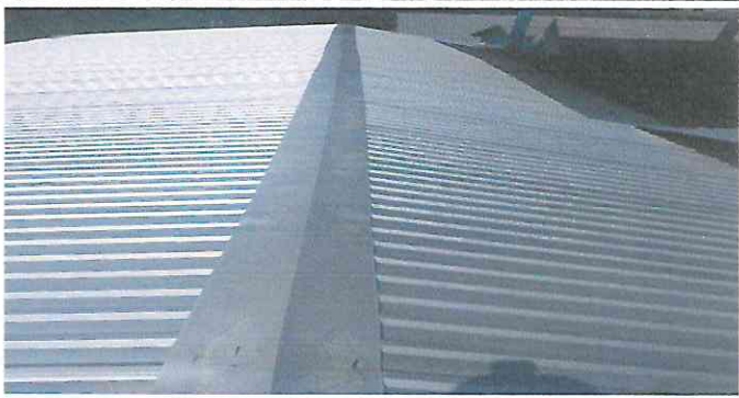
Foto 2: Sustitucion de 42 ML capotes de lamina acanalada, para lamina troquelada, calibre 26.
