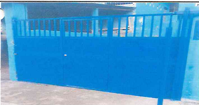
Foto 5: Sustitucion de un porton de barrotes de hierro por porton de tubo cuadrado y metal.
