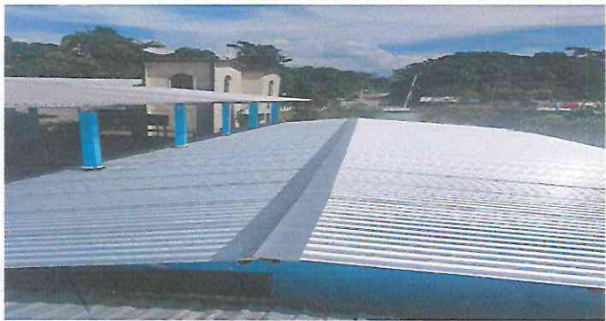
Foto1: Sustitucion de 397.32 M2 de lamina acanalada por lamina troquelada. Calibre 26
