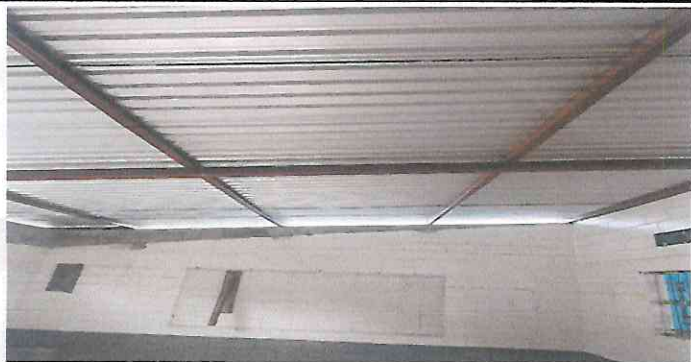
Foto 3: Mantenimiento de 369 M2 a estructura de soporte de metal con anticorrosivo
