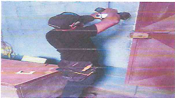
FOTO No. 9. Sustitución de 9 tomacorrientes dobles
