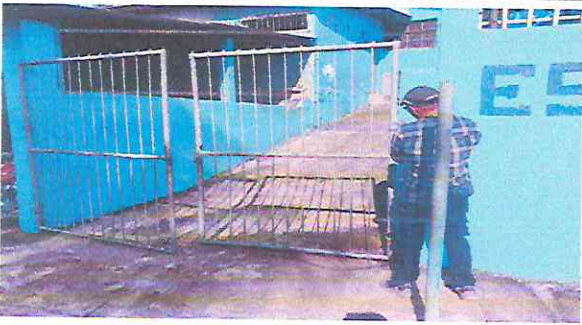
FOTO No. 5. Sustrución de un portón de barotes de hierro por portón de tubo cuadrado y metal.
