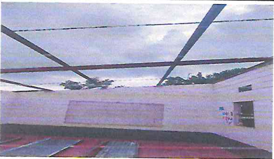
FOTO NO. 3 Mantenimiento de 368 m2 a estructura de soporte de meyal con anticorrosivo.
