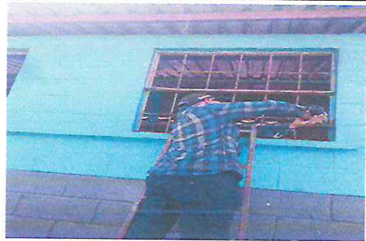
FOTO No. 4. Sustrución de 11 m2 de balcones de barotes de hierro por tubo cuadrado de 1".
