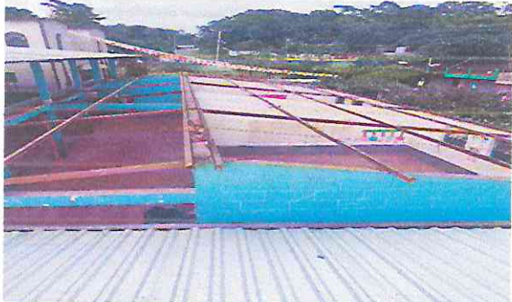
FOTO No. 1. Sustrución de 397.32 m2 de lamina acanalada por lamina troquelada calibre 26.
