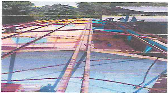
FOTO No. 2. Sustrución de 42 ML de capote de lamina acanalada para lamina troquelada calibre 26.
