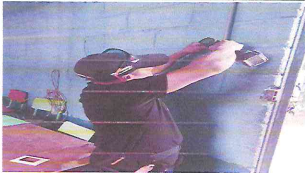
FOTO No. 8. Sustitución de 8 interruptores simples por interruptores dobles
