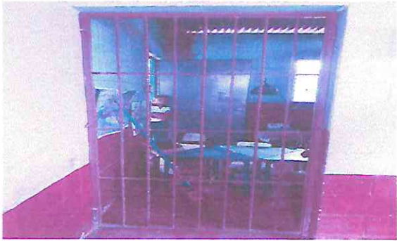
FOTO No. 7 Sustitución de una puerta de barrotes de hierro por puerta de metal.
