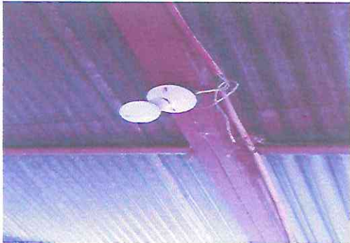
FOTO No.10. Sustitución de 12 bombillos LED GLOBO 30W 2400 Lúmenes
