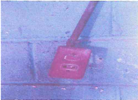
FOTO No.8. Sustitución de 8 interruptores simples por interruptores dobles.
