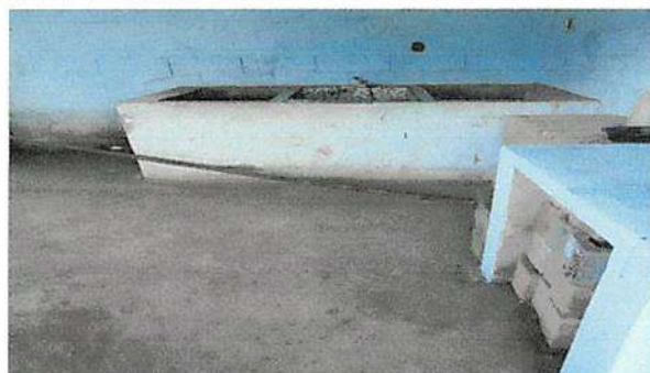
Foto 8: Sustitución de piso de granito en cocina
