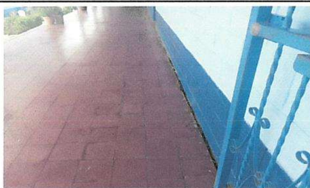
Foto 10: Sustitución de piso de cerámico en corredor
