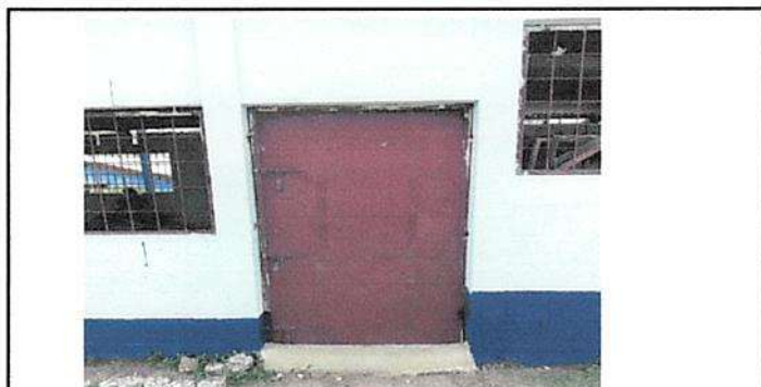
Foto 5: Mantenimiento a estructura (lijado, cambio de tubo, cepillado, sujeciones, aplicación de pintura) cocina.
