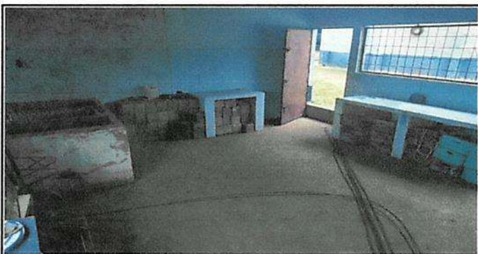
Foto 11: Reparación de azulejo en muebles de cocina
