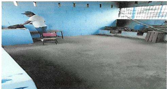
Foto 7: Sustitución de piso de granito en cocina
