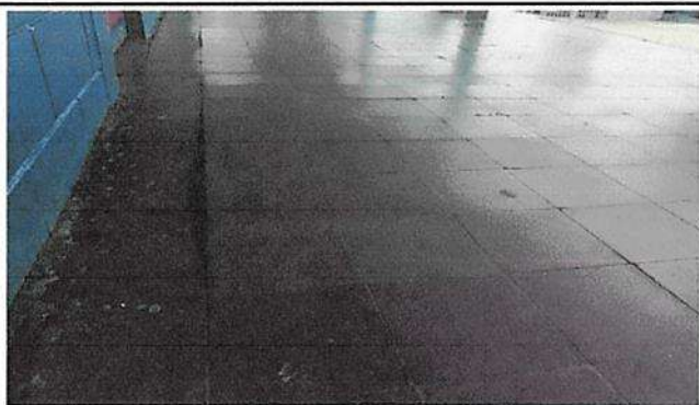
Foto 9: Sustitución de piso de cerámico en corredor
