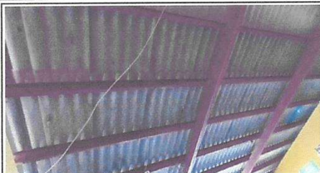
Foto1: Mantenimiento a estructura de soporte de metal
