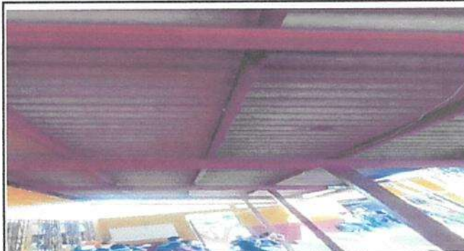
Foto 1: Mantenimiento a estructura de soporte de metal
