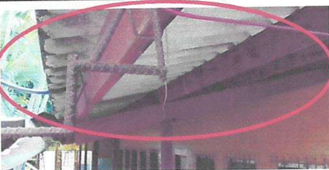
Mantenimiento a estructura de soporte de metal
