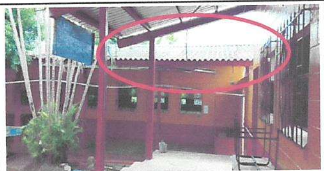
Instalación de lámina troquelada aluzinc
