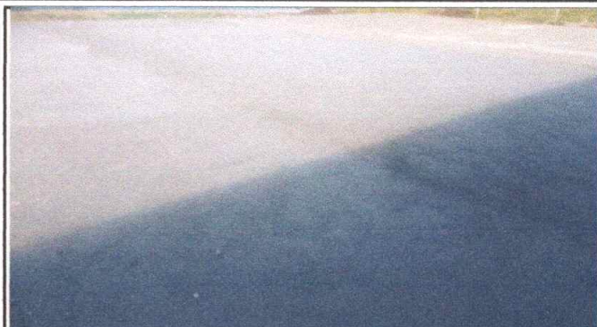
Foto 2: Sustrucion de plancha de concreto de patio 240m2
