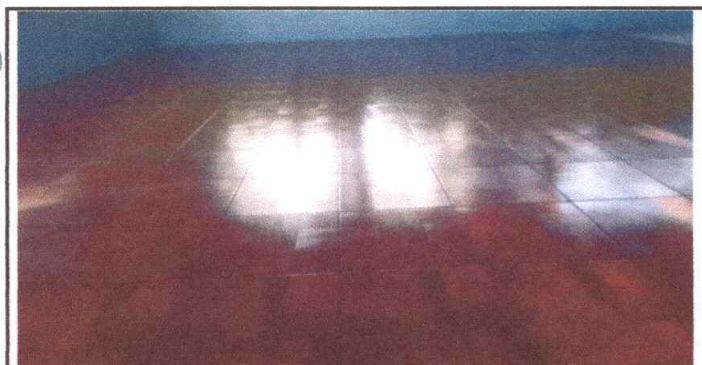
Foto 2: Sustrución de piso de granito por piso cerámico 205mts2
