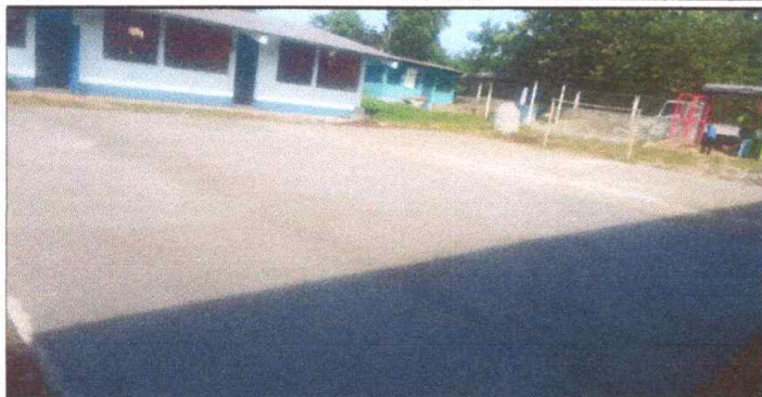
Foto 1: Sustrucion de plancha de concreto de patio 240m2
