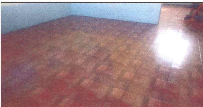
Foto 3: Sustrución de piso de granito por piso cerámico 205mts2
