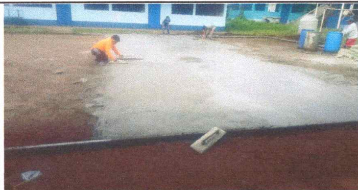
Foto 1: Sustitucion de plancha de concreto de patio 240m2
