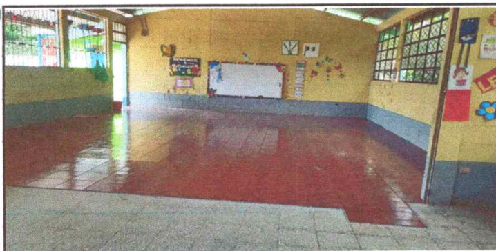
Foto 1: Sustitución de piso de granito por piso cerámico 205mts2
