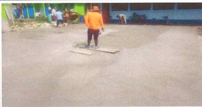
Foto 3: Sustitucion de plancha de concreto de patio 240m2
