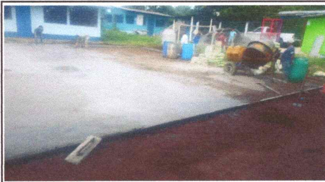
Foto 2: Sustitucion de plancha de concreto de patio 240m2
