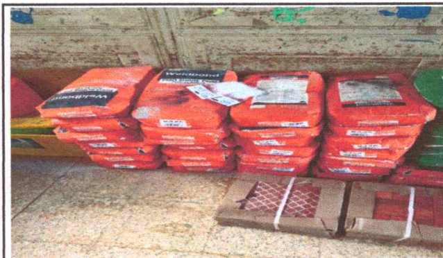
Foto 1: Sustitución de piso de granito por piso cerámico 205mts2
