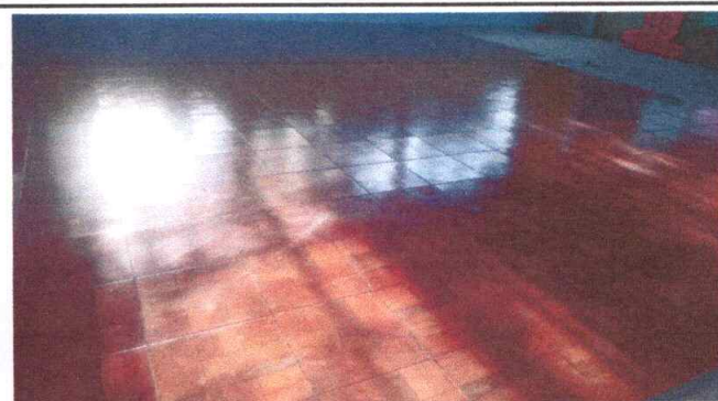
Foto 1: Sustitución de piso de granito por piso cerámico 205mts2
