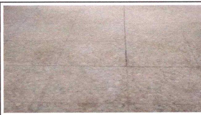
Foto 1: Sustrucion de piso de granito por piso cerámico 205mts2
