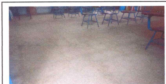
Foto 2: Sustrucion de piso de granito por piso cerámico 205mts2
