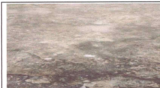
Foto 3: Sustrucion de plancha de concreto de patio 240m2
