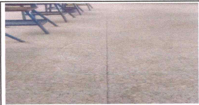
Foto 3: Sustrucion de piso de granito por piso cerámico 205mts2
