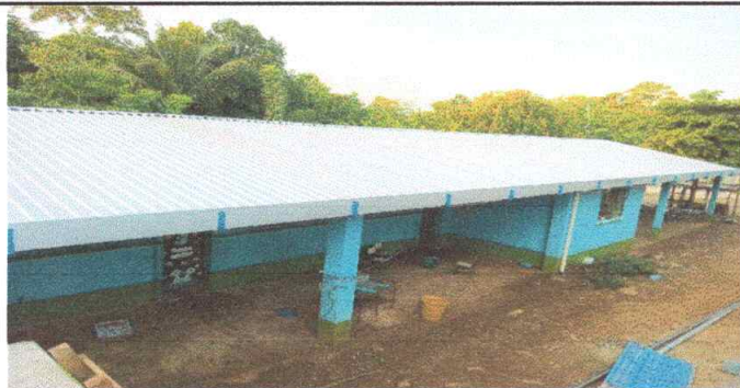
Foto1: Sustitucion de lámina por lámina troquelada calibre 26, 300 M2.
