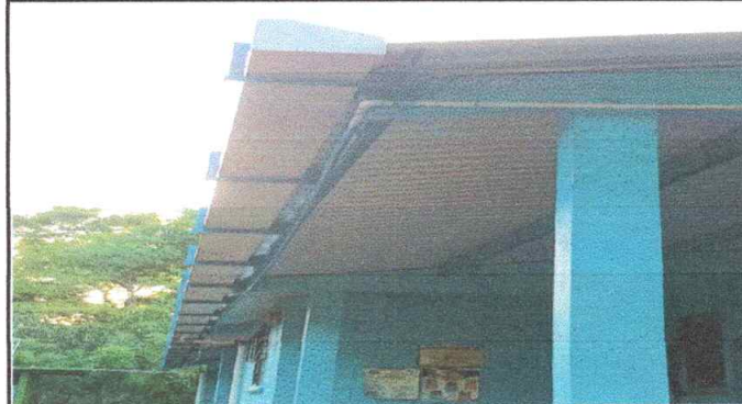
Foto 4: Sustitución de canal de metal, 27 ML
