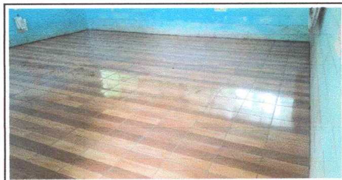
Foto 6: Sustitucion de piso cerámico, 88 M2
