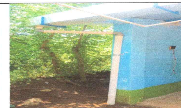
Foto 5: sustitucion de bajada de agua pluvial con tubo pvc 4", 30 ML
