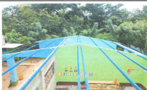
Foto 2: Mantenimiento a estructura de soporte de metal con anticorrosivo, 150 M2.
