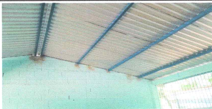
Foto 3: Sustitución de estructura de soporte de metal por metal, 150 M2.
