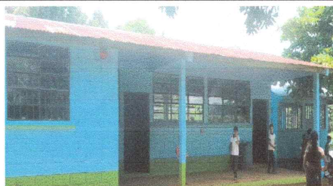
Foto 4: sustitución de canal de metal, 27 metros cuadrados.
