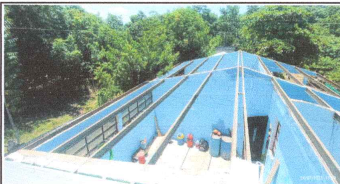
Foto 2: Mantenimiento a estructura de soporte de metal con anticorrosivo 150 metros cuadrados.
