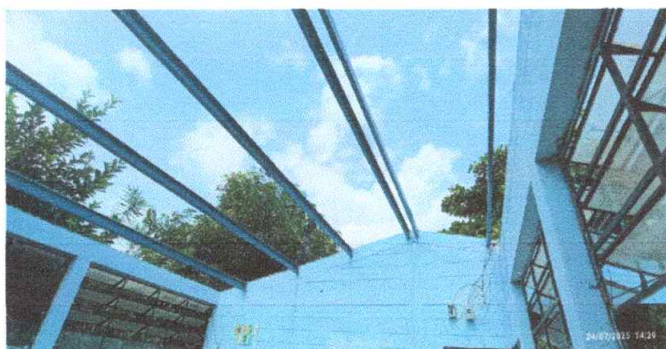
Foto 3: sustitución de estructura de soporte de metal por metal, 150 metros cuadrados.
