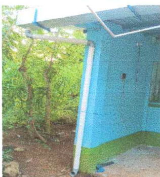
foto 5: Sustitucion de bajada de agua pluvial con tubo pvc 4", 30 ml
