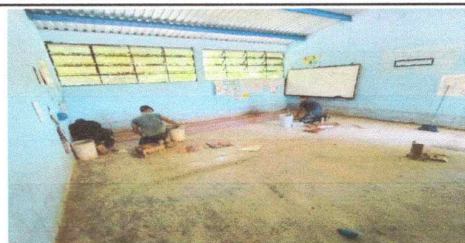
foto 6: Sustitución de piso cerámico, 88 metros cuadrados
