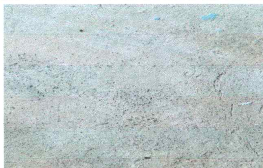
foto 6: Sustitución de piso cerámico
