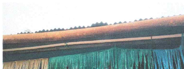
Foto 4: Sustitución de canal de metal
