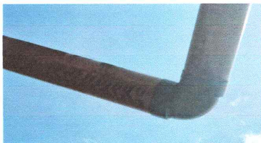
Foto 5: Sustitución de bajada de agua pluvial con tubo pvc 4"
