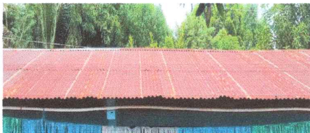
Foto 1: Sustitución de lámina, por lámina troquelada calibre 26
