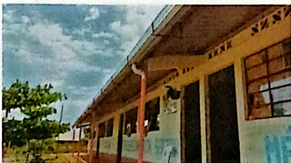
Foto 5: Mantenimiento correctivo techo con bajadas de agua pluvial 3" en techo 25 metros lineales.
