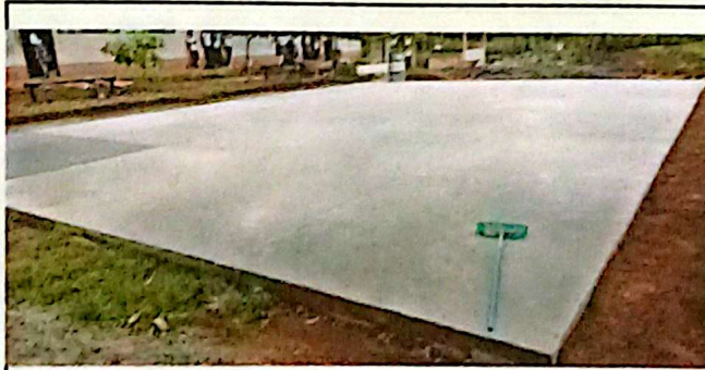
Foto 4: Mantenimiento correctivo de piso de cancha, sustitución de pavimento de concreto hidráulico 210Kg/cm 2 reforzado con fibra control de agrietamiento (demolición, conformación de base, concreto hidráulico) 150m 2
