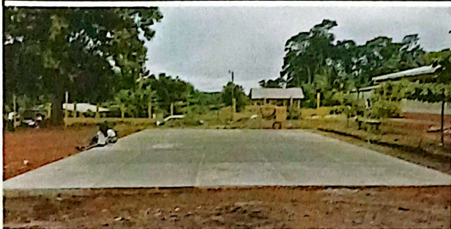
Foto 1: Mantenimiento correctivo de piso de cancha sustitución de pavimento de concreto hidráulico 210Kg/cm 2 reforzado con fibra control de agrietamiento (demolición conformación de base concreto hidráulico) mantenimiento correctivo, reposición de bordillo con tabique 30 metros lineales 150m 2 de concreto.
