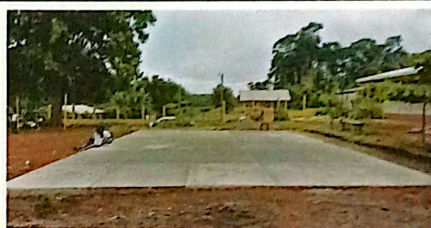
Foto 2: Mantenimiento correctivo de piso de cancha sustitución de pavimento de concreto hidráulico 210Kg/cm 2 reforzado con fibra de control de agrietamiento (demolición conformación de base concreto hidráulico) 150m 2
