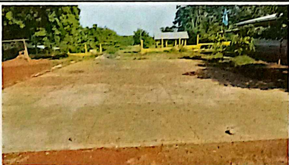
Foto 3: Mantenimiento correctivo de piso de cancha, sustitución de pavimento de concreto hidráulico 210Kg/cm 2 reforzado con fibra de control de agrietamiento (demolición de base, concreto hidráulico) 150m 2
