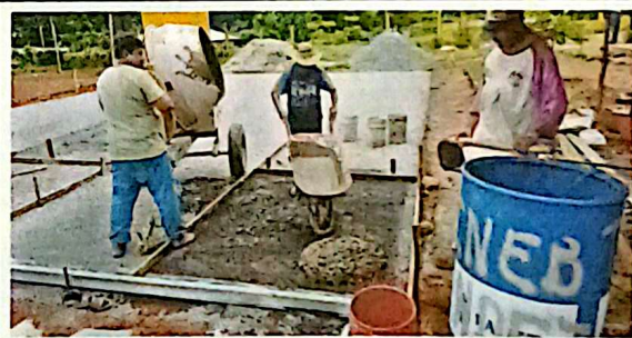
Foto 4: Mantenimiento correctivo de piso de cancha sustitución de pavimento de concreto hidráulico 210 Kg/cm² reforzado con fibra de control de agrietamiento, (demolición, conformación de base, concreto hidráulico) 150m².
