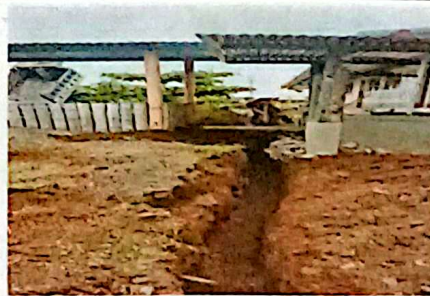
Foto 6: Mantenimiento correctivo sustitución de 42 metros lineales de drenaje de agua pluvial 4" PVC.
