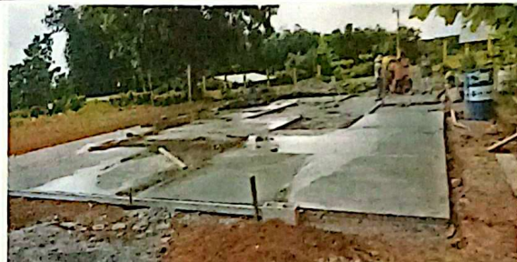
Foto 2: Mantenimiento correctivo de piso de cancha sustitución de pavimento de concreto hidráulico 210 Kg/cm² reforzado con fibra de control de agrietamiento (demolición conformación de base concreto hidráulico 150 m²).
