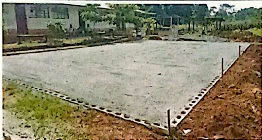
Foto 1: Mantenimiento correctivo de piso de cancha sustitución de pavimento de concreto hidráulico 210 Kg/cm² reforzado con fibra de control de agrietamiento, (demolición, conformación de base, concreto hidráulico) 150m².
