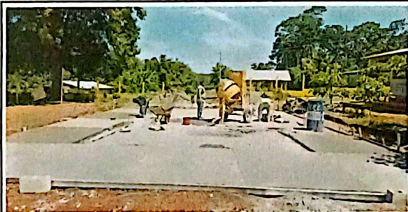
Foto 3: Mantenimiento correctivo de piso de cancha sustitución de pavimento de concreto hidráulico 210 Kg/cm² reforzado con fibra de control de agrietamiento, (demolición, conformación de base, concreto hidráulico) 150m².
