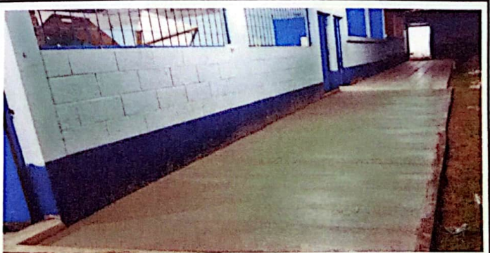
Foto # 6: REPARACIÓN Y SUSTITUCIÓN DE ENTORTADO 60 m2
