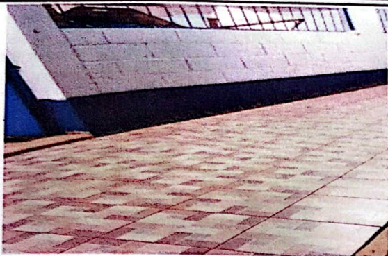
Foto # 7: REPARACIÓN DE PISO CERÁMICO 30 m2
