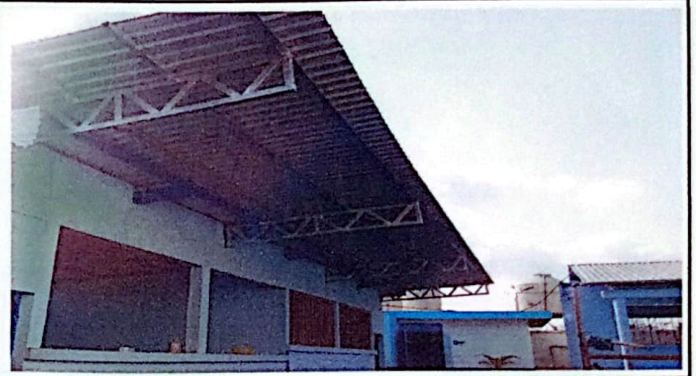
Foto # 2: SUSTITUCIÓN DE ESTRUCTURA METÁLICA 65 m2
