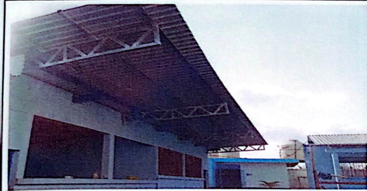
Foto # 1: CUBIERTA DE LAMINA 55 ML
