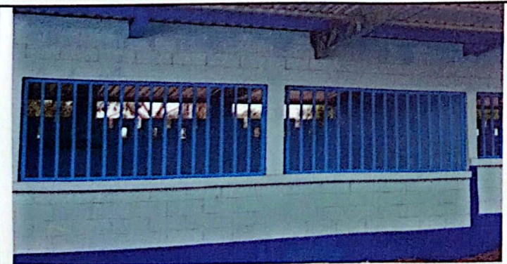
Foto # 5: MANTENIMIENTO DE BALCONES 7.5 m2
