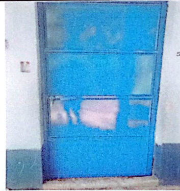
Foto # 4: SUSTITUCIÓN Y MANTENIMIENTO DE 4 PUERTAS
