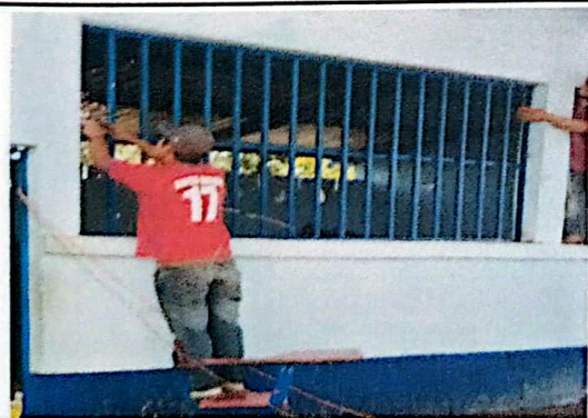
Foto # 5: MANTENIMIENTO DE BALCONES 7.5 m2
