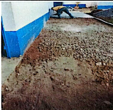
Foto # 6: REPARACIÓN Y SUSTITUCIÓN DE ENTORTADO 60 m2
