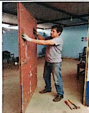
Foto # 4: SUSTITUCIÓN Y MANTENIMIENTO DE 4 PUERTAS
