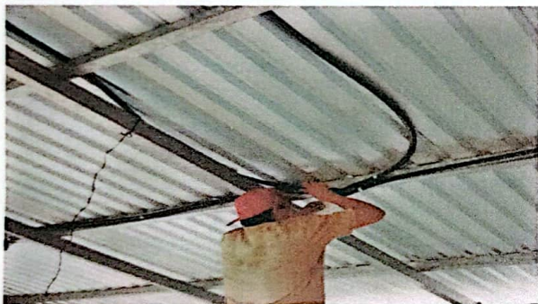
Foto # 3: SUSTITUCIÓN DE SISTEMA ELÉCTRICO 1000 ML
