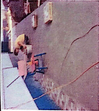
Foto # 7: REPARACIÓN DE PISO CERÁMICO 30 m2
