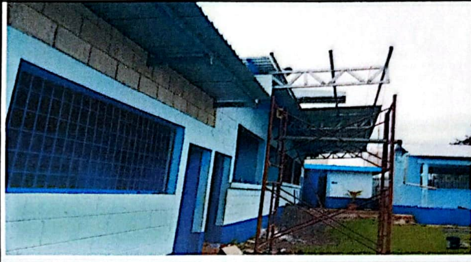
Foto # 2: SUSTITUCIÓN DE ESTRUCTURA METÁLICA 65 m2
