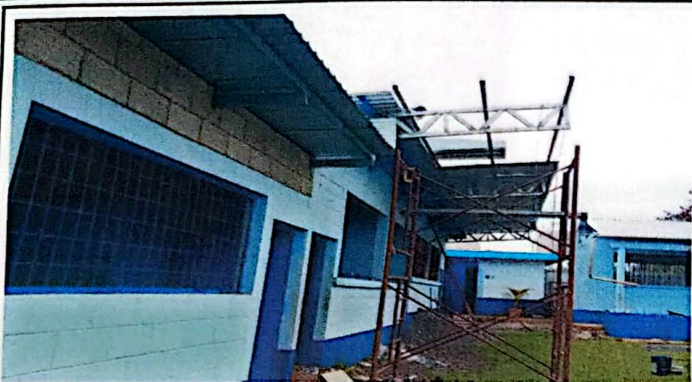
Foto # 1: CUBIERTA DE LAMINA 55 ML
