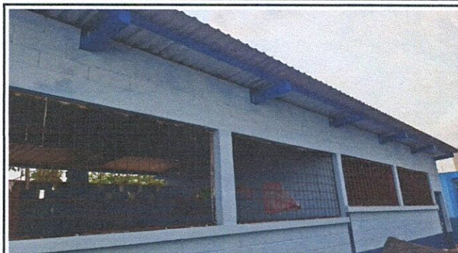
Foto # 2: SUSTITUCIÓN DE ESTRUCTURA METÁLICA
