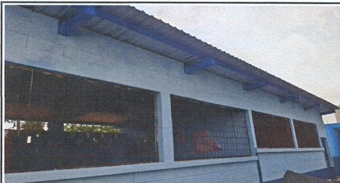
Foto # 1: CUBIERTA DE LAMINA
