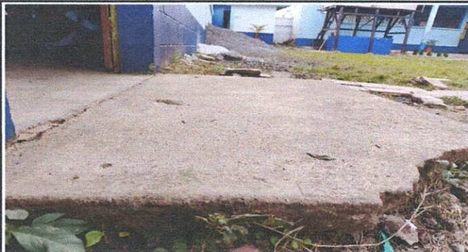
Foto # 7: REPARACIÓN DE PISO CERÁMICO
