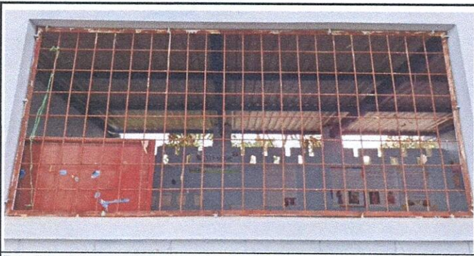
Foto # 5: MANTENIMIENTO DE BALCONES
