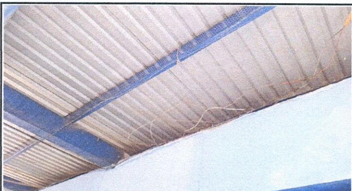
Foto # 3: SUSTITUCIÓN DE SISTEMA ELÉCTRICO
