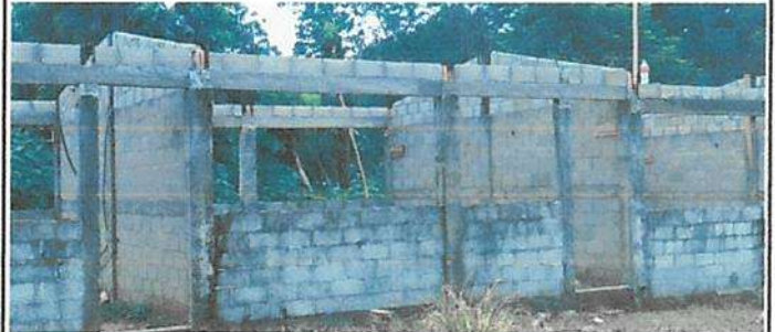
Foto 2: Sustrucción de estructura de metal
