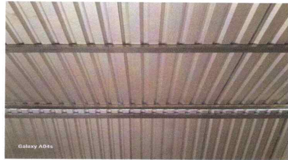
Foto 16: Instalación terminada de estructura de soporte de madera por metal
