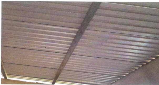
Foto 15: Instalación de lámina por lámina troquelada
