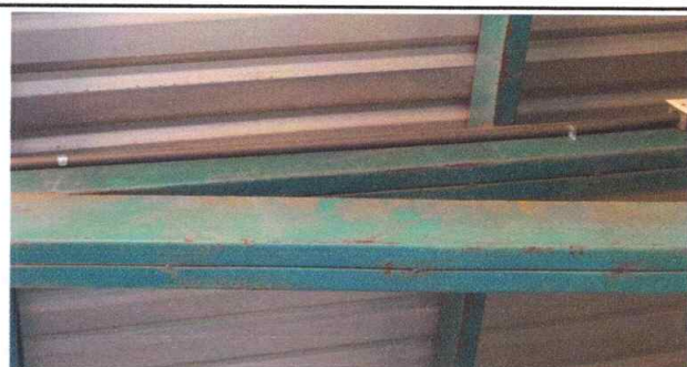
Foto 6: Instalación de cableado #12
