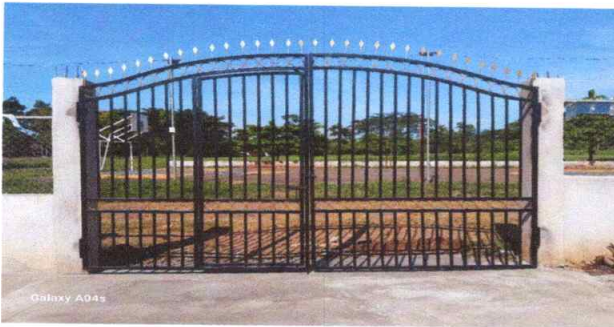
FOTO # 9: Instalación de portón metálico de 3.70X2.20 metros de lámina de 3/64
