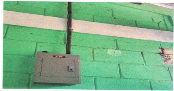
Foto 8: Instalación de flipón 30-50 AMP 2 POLOS
