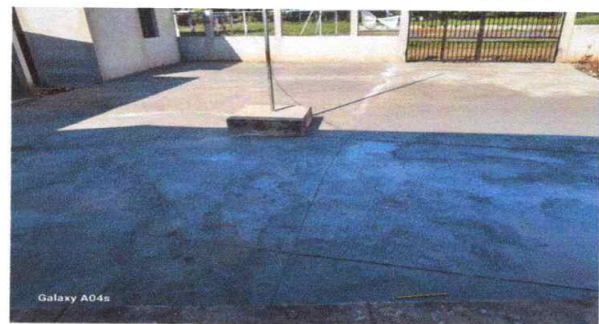
Foto 12: Instalación terminada de torta de concreto de 10cm de grosor
