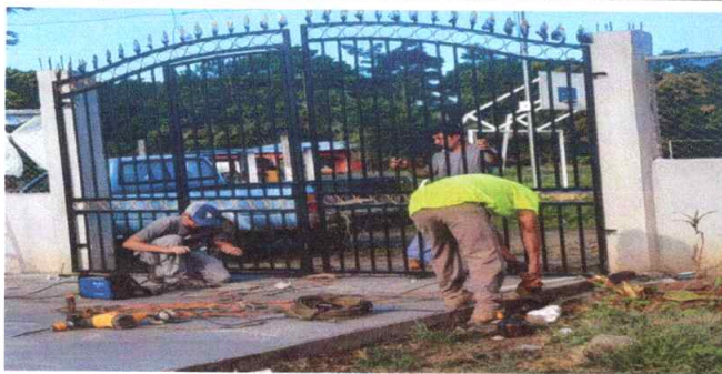
Foto 9: Sustitución de portón en proceso
