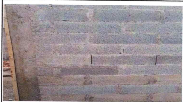
Foto 14: En proceso, sustitución y reparación de muro con block
