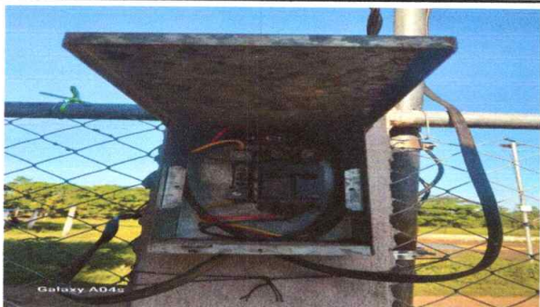
Foto # 5: Sustitución de tablero principal de 6x110V
