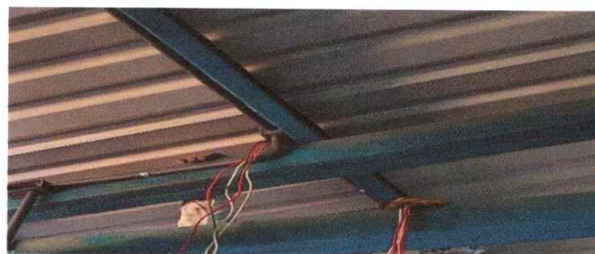
Foto 6: Reparación y sustitución de cableado #12
