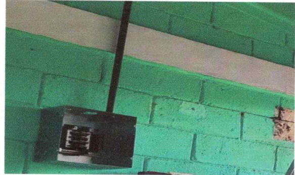
FOTO 8: Trabajo en proceso sustitución de flipón 30-50 AÑO 2 POLOS
