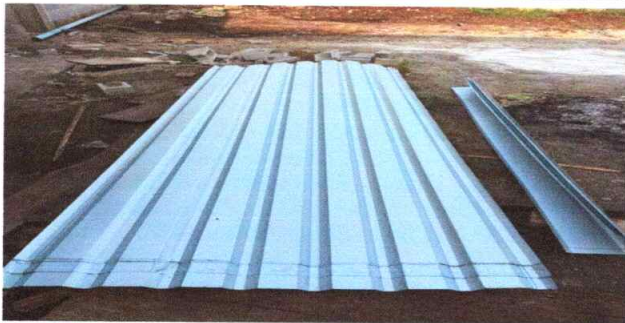
Foto 15: En proceso, sustitución de lámina por lámina troquelada calibre 26
