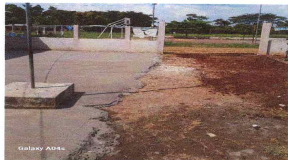
Foto 12: Trabajo en proceso de sustitución e instalación de torta de concreto de 10cm de grosor
