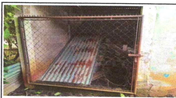
FOTO 10: Sustitución de puerta metálica
