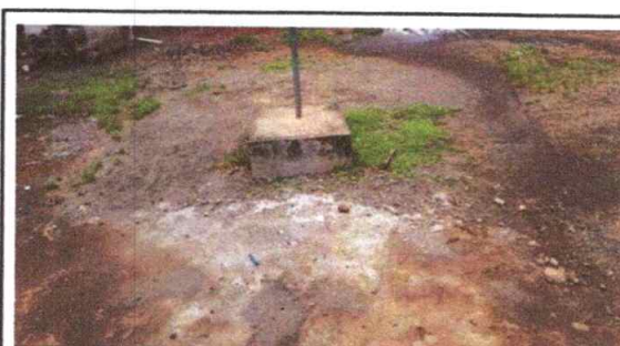
FOTO 12: Sustitución e instalación de torta de cemento de 10 cm de grosor
