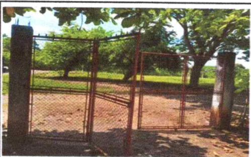
FOTO 9: Sustitución de portón metálico de 30x 2.20 metros, de lámina de 3/64
