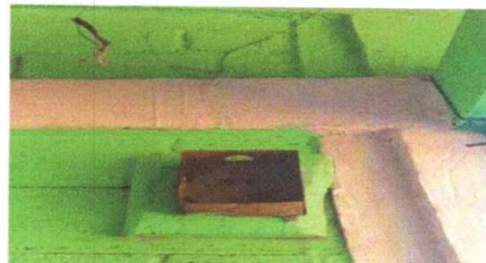
FOTO 8: Reparación y sustitución de flapon 30-50 AMP 2 POLOS
