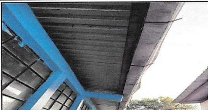
Foto 7: Sustrucción de canal de metal
