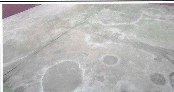
Foto 6: Sustitución de piso de torta de concreto
