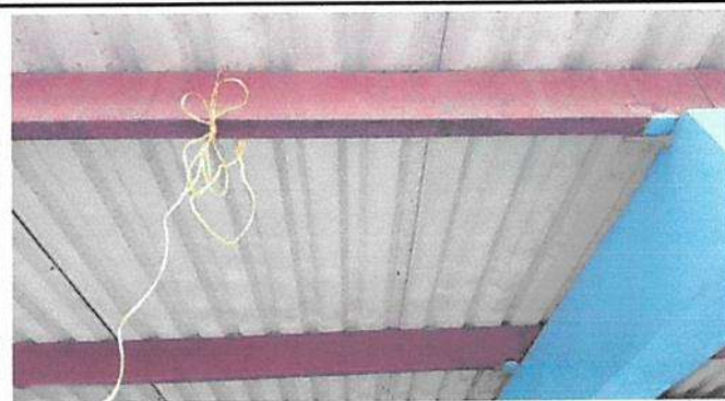
Foto 2: Mantenimiento a estructura de soporte de metal
