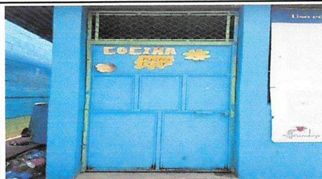
Foto 4: Mantenimiento a estructura ( ligado, cambio de tubo, sepillado, sujeciones, aplicación de pintura)
