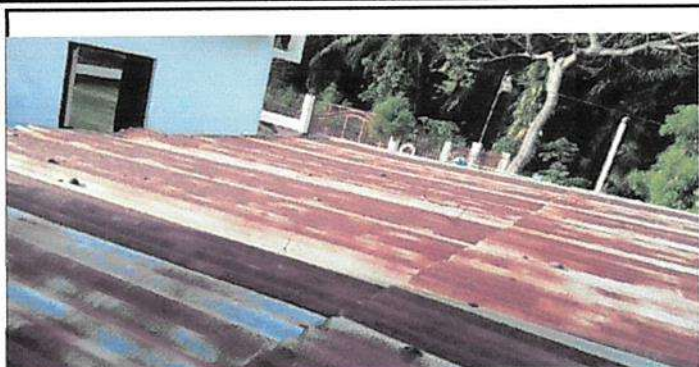
Foto 1: Sutiución de lamina por lamina troquelada
