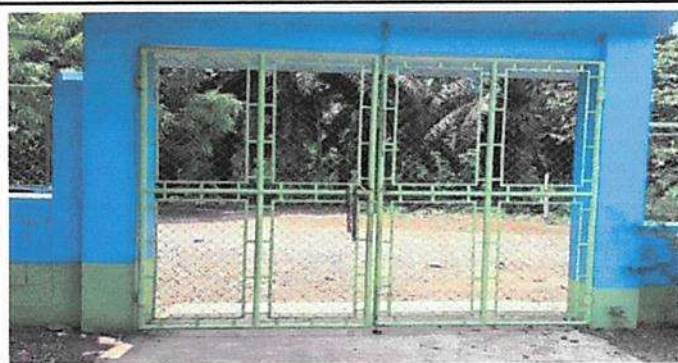
Foto 11: Mantenimiento a portones de metal
