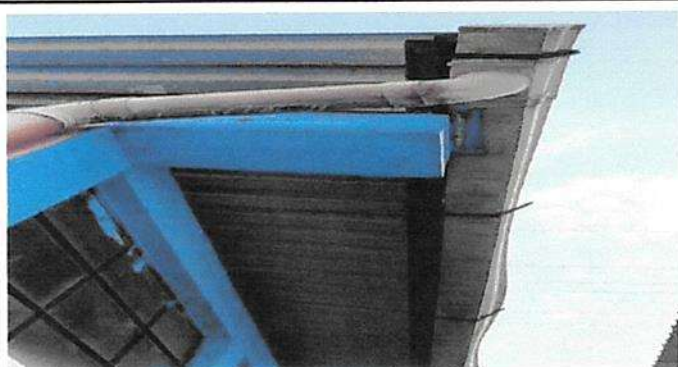
Foto 9: Sustrucción de soporte o pescante para canal
