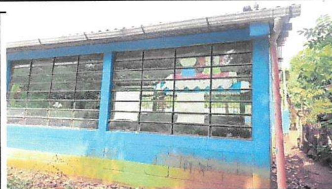
Foto 10: Pintura en muros exteriores e interiores
