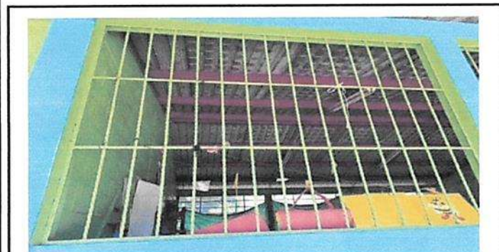
Foto 5: Mantenimiento a valcones de metal
