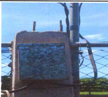
Foto 5: Terminación e instalación de tablero principal
