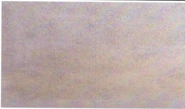
Foto 13: Acabado de muro con block
