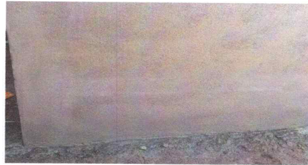
Foto 14: Acabado de muro con block
