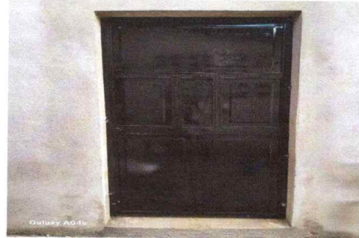
Foto 10: Instalación de puerta metálica 1.50X2 mts
