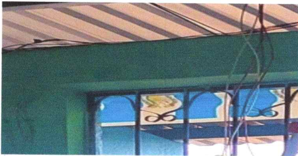
Foto 7: En proceso sustitución de cableado # 10
