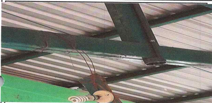
Foto1: En proceso cambio de plafonera
