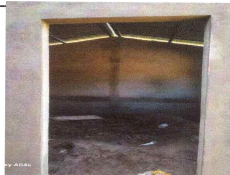
Foto 10: Trabajo en proceso de sustitución de puerta metálica
