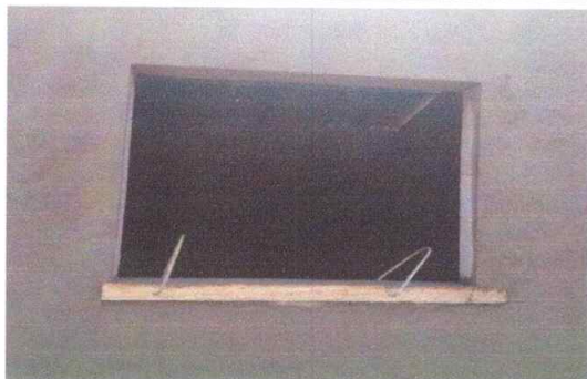
Foto 11: Trabajo en proceso de sustitución estructura de ventana
