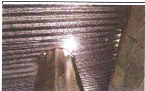
FOTO 15: Sustrución de lámina, por lamina troquelada calibre 26
