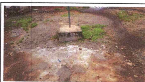
FOTO 12: Sustitución e instalación de torta de cemento de 10 cm de grosor
