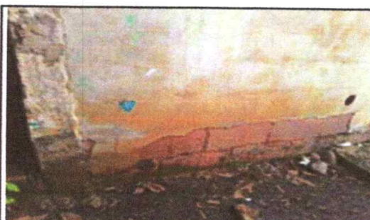
FOTO 14: Sustrución y reparación de muro con block
