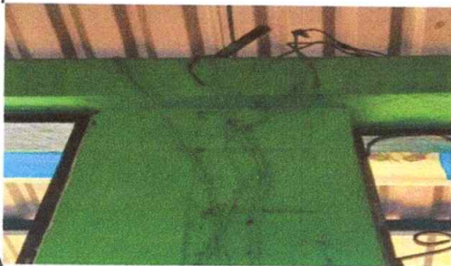
FOTO 7: Sustitución y reparación de cableado # 10
