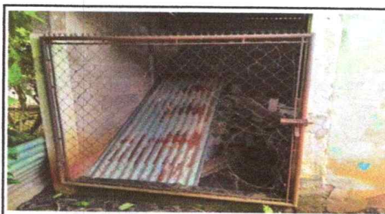
FOTO 10: Sustitución de puerta metálica
