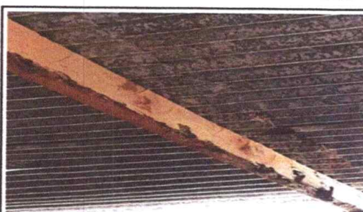
FOTO 16: Sustrución de estructura de soporte de madera por metal
