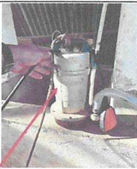
Foto 5: Sustrucción de bomba de agua.
