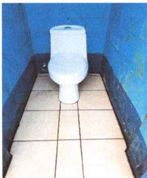
FOTO 1.6 Unidades de sustitución de sanitario elongado.
