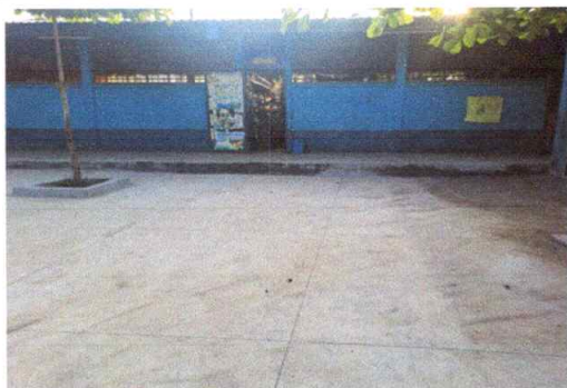
FOTO 3. 200 Metros cuadrados de saustitución de piso de torta de concreto de 10 cm de grosor.
