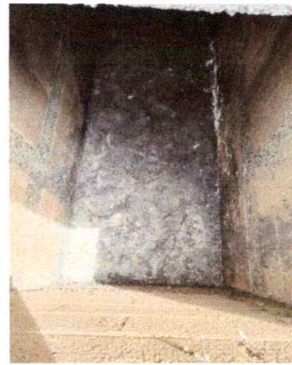
FOTO 2. 5 Metros cubicos de limpieza de fosa séptica.
