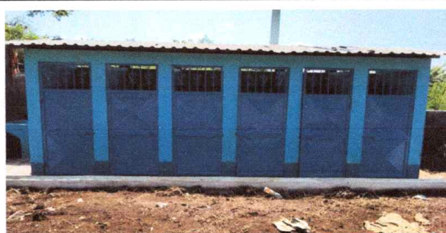
FOTO 6. 6 Metros Cuadrados de mantenimiento a estructura de puertas (lijado, sujeciones y aplicación de pintura).
