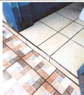
FOTO 4. 14 Metros cuadrados de sustitución de piso ceramico en baños.
