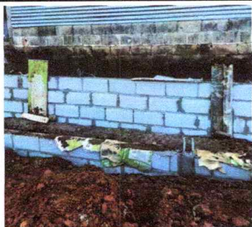
FOTO 5: 60 Metros cuadrados de reparación de muro con block 50 kg/cm2 14x19x39cm.
