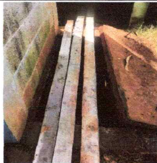
FOTO 2.5 Metros cubicos de limpieza de fosa séptica.
