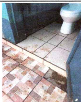
FOTO 4. 14 Metros cuadrados de sustitución de piso ceramico en baños.
