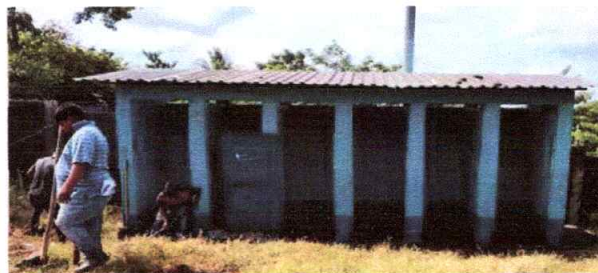
FOTO 6: 6 Metros cuadrados de mantenimiento a estructura de puertas (lijado, sepillado, sujeciones y aplicación de pintura).
