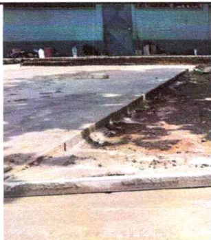
FOTO 3. 200 Metros cuadrados de sustitución de piso de torta de concreto de 10 cm de grosor.
