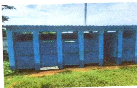
FOTO 6: 6 Metros cuadrados de mantenimiento a estructura de puertas (lijado, sepillado, sujeciones y aplicación de pintura).
