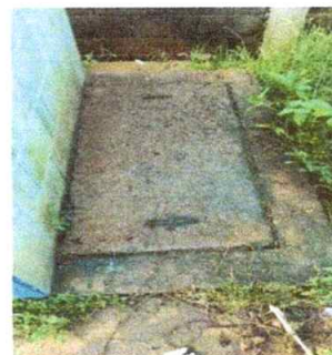
FOTO 2. 5 Metros cubicos de limpieza de fosa séptica.
