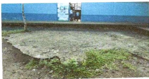
FOTO 3. 200 Metros cuadrados de sustitución de piso de torta de concreto de 10 cm de grosor.
