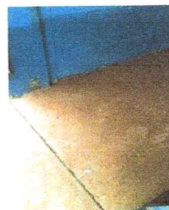
FOTO 4. 14 Metros cuadrados de sustitución de piso ceramico en baños.
