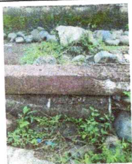
FOTO 5: 60 Metros cuadrados de reparación de muro con block 50 kg/cm2 14x19x39cm.
