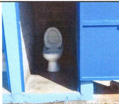
Foto 8: Sustrución de inodoro elongado, 2 unidades
