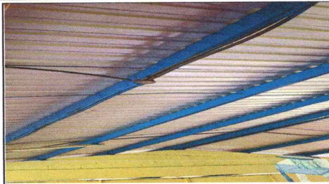
Foto 2: Mantenimiento a estructura de soporte de metal con anticorrosivo, 202 m2
