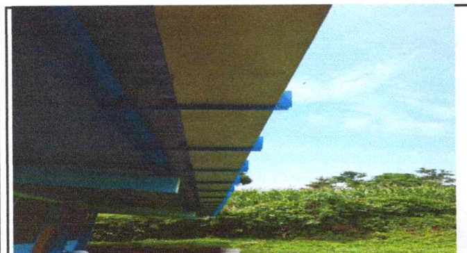
Foto 3: Sustitución de canal de metal, 20 ML
