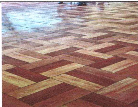
Foto 7: Sustrución de piso ceramico, 125 m2
