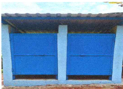
Foto 9: Mantenimiento correctivo de muros con reparación de muro con columnas de 0.15x0.15x2.50m + reparación con muro con block 50 kg/cm2 14x19x39. Total columnas 4 m2 12, 20 m2
