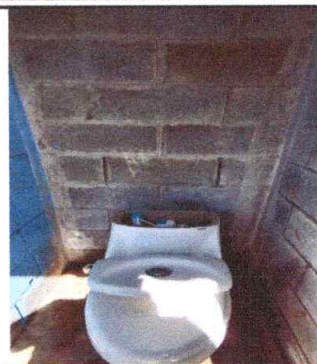
Foto 8: Sustitución de inodoro elongado, 2 unidades
