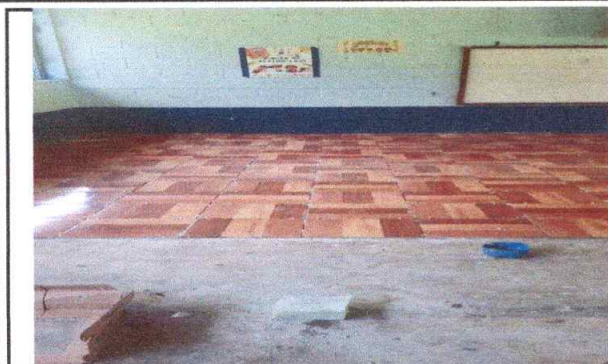
Foto 7: Sustitución de piso ceramico, 125 m2
