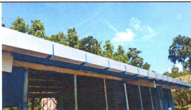
Foto 3: Sustitución de canal de metal 20 ML
