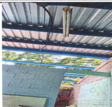
Foto 2: Mantenimiento a estructura de soporte de metal con anticorrosivo, 202 m2
