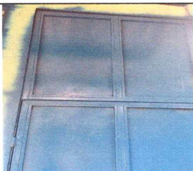
Foto 5: Mantenimiento de estructura de puerta lijado, cepillado, y aplicación de pintura, 6 m2
