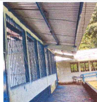
Foto 6: Mantenimiento de balcones, 70 m2
