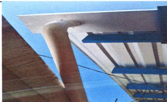
Foto 4: Reparación de bajada de agua pluvial, de tubo PVC 4", 30 ML
