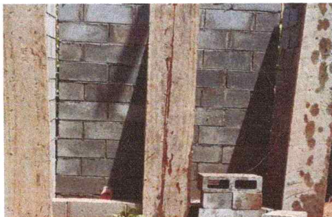
Foto 9: Mantenimiento correctivo de muros con reparación de muro con columnas de 0.15x0.15x2.50m + reparación con muro con block 50 kg/cm2 14x19x39. Total columnas 4 m2 12, 20 m2
