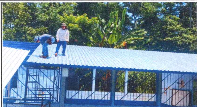
Foto 1: Sustitución de lámina, por lámina troquelada calibre 26, 202 m2
