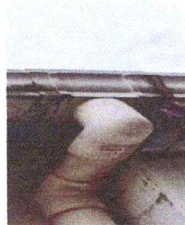
Foto 4: Reparación de bajada de agua pluvial, de tubo PVC 4"
