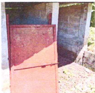
Foto 9: Mantenimiento Correctivo de muros con Reparación de muro con columnas de 0.15x0.15x2.50m + Reparación de muro con block 50 kg/cm2 14x19x39. Total columnas 4 mts2 12
