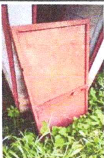
Foto 5: Mantenimiento a estructura de puerta lijado, cepillado y aplicación de pintura
