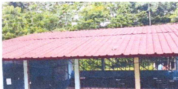
Foto 1: Sustitucion de lámina, por lámina troquelada calibre 26
