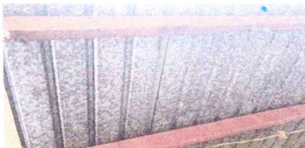
Foto 2: Mantenimiento a estructura de soporte de metal con anticorrosivo
