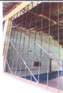
Foto 6: Mantenimiento de balcones
