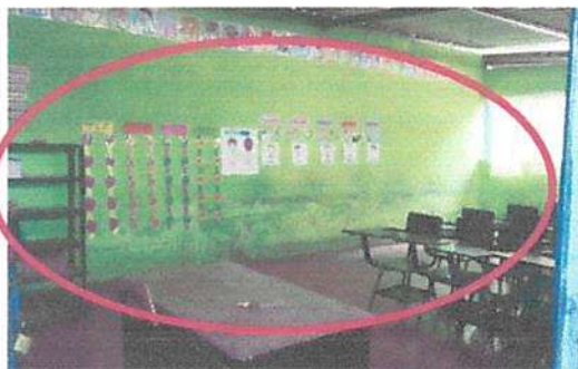
Sellado de grietas y fisuras en muros
