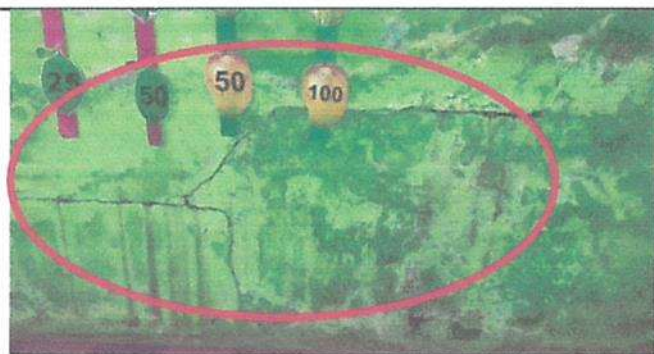
Sustitución preventiva de columnas de concreto
