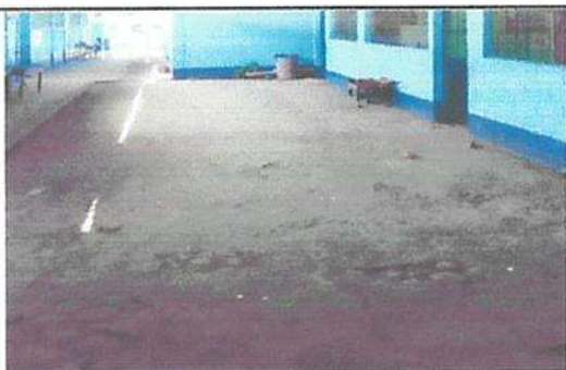
Sustitución de piso de torta de concreto
