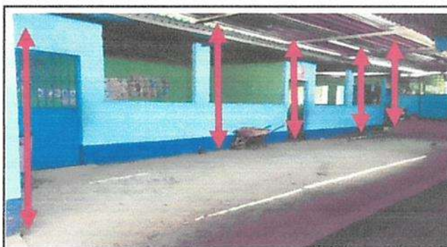
Sustitución preventiva de columnas de concreto
