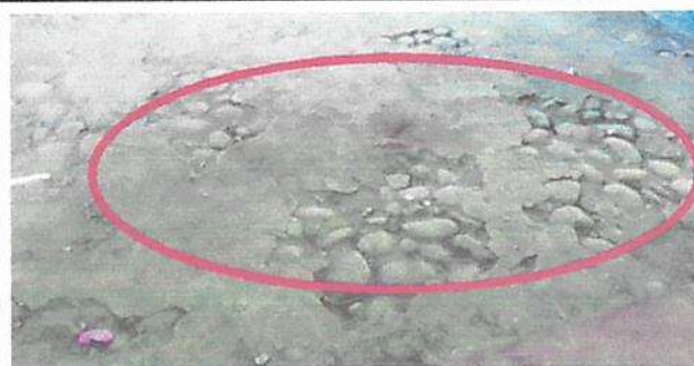
Sustitución de piso de torta de concreto
