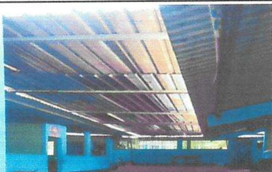
Sustitución de canal de metal
