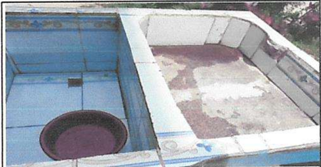
Foto 6: Sustitución de Pila.
