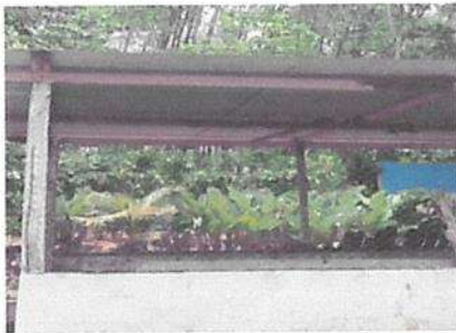
Foto 3: Reparación de muro perimetral de block, con tubo y malla galvanizada soleras intermedias y columnas.
