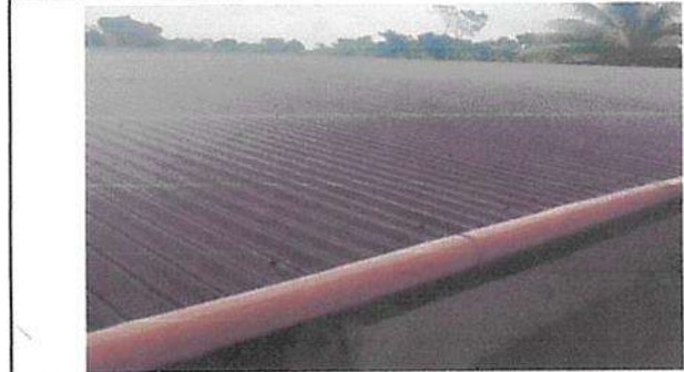
Foto 2: Sustitución de Techo de lamina troquelada aluzinc calibre 26
