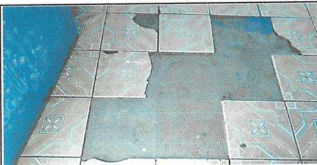
Sustitución de piso cerámico
