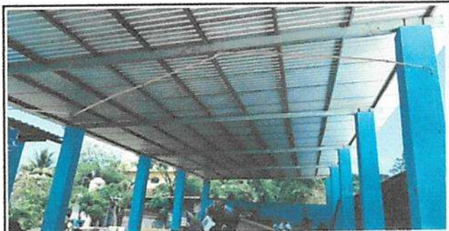
Reparación de cableado eléctrico calibre 12 AWG
