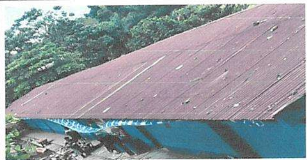
Sustitución de lámina, por lámina troquelada calibre 26
