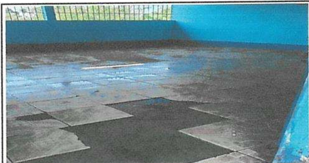
Sustitución de piso cerámico
