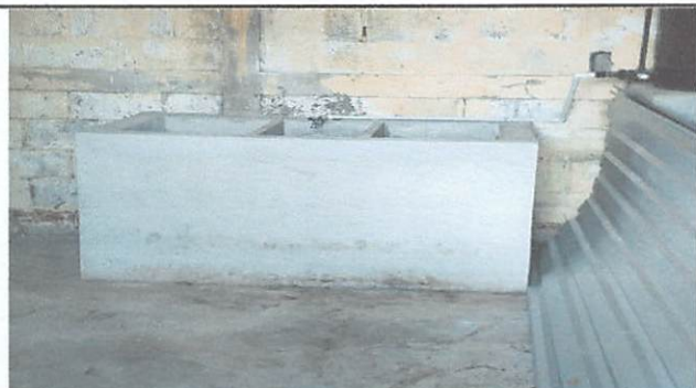
Foto #5: Sustitución de pila de concreto de dos lavaderos, 1 unidad
