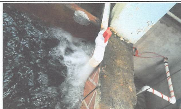
Foto #4: Sustitución de sistema de agua potable con bomba sumergible de 1HP, 1 unidad
