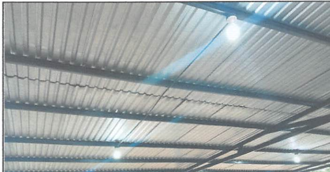
Foto #6: Sustitución de sistema eléctrico, 180 MI
