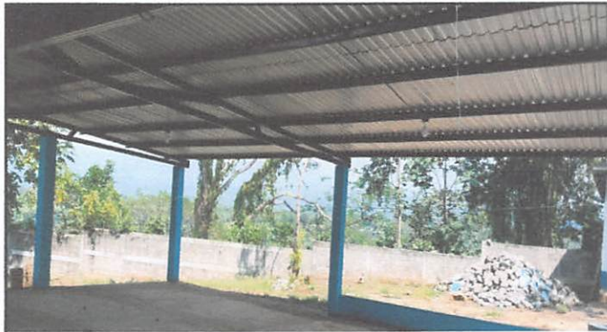
Foto #2: Sustitución de lámina, por lámina troquelada cal. 26, 270 m2
