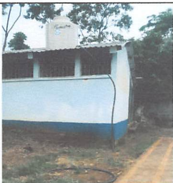
Foto #3: Reparación y mantenimiento de depósito de agua, 1 Unidad
