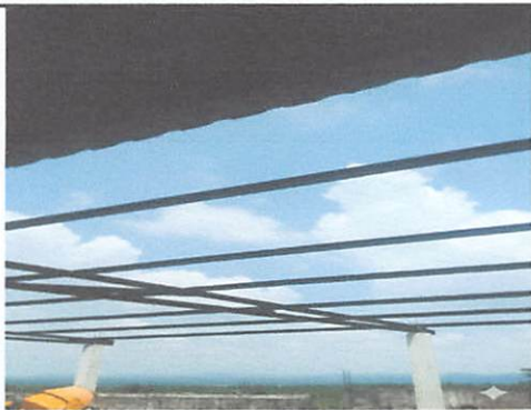
Foto #1: Sustitución de estructura de soporte de metal, por metal, 270 m2
