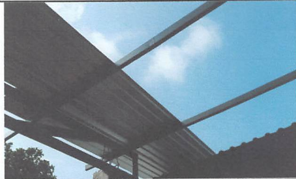
Foto #2: Sustrucción de lámina, por lámina troquelada cal. 26, 270 m2
