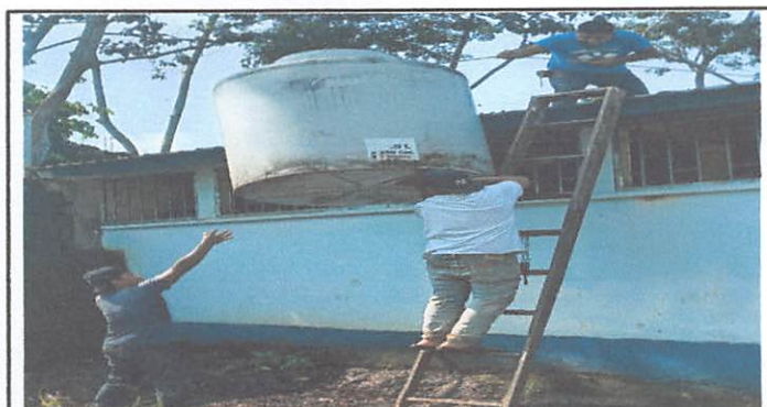
Foto #3: Reparación y mantenimiento de depósito de agua, 1 Unidad
