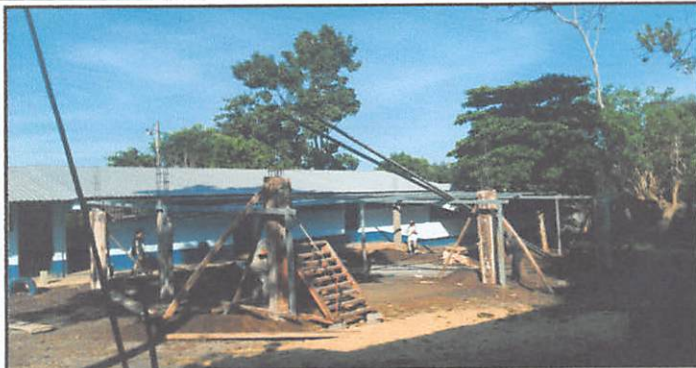
Foto #1: Sustrucción de estructura de soporte de metal, por metal, 270 m2
