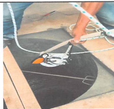
Foto #4: Sustrucción de sistema de agua potable con bomba sumergible de 1HP, 1 unidad
