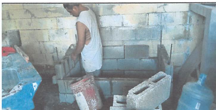
Foto #5: Sustrucción de pila de concreto de dos lavaderos, 1 unidad
