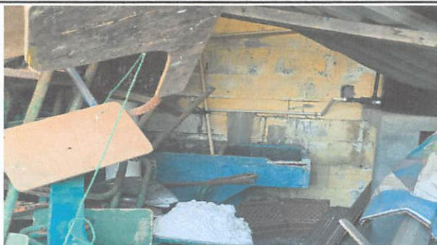
Foto #5: Sustrucción de pila de concreto de dos lavaderos, 1 unidad
