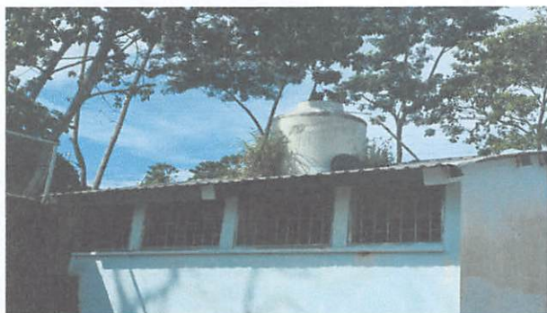
Foto #3: Reparación y mantenimiento de depósito de agua, 1 Unidad
