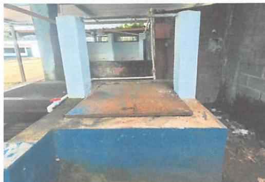
Foto #4: Sustrucción de sistema de agua potable con bomba sumergible de 1HP, 1 unidad
