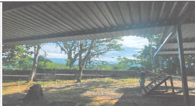
Foto #1: Sustrucción de estructura de soporte de metal, por metal, 270 m2
