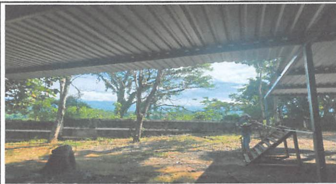
Foto #2: Sustrucción de lámina, por lámina troquelada cal. 26, 270 m2
