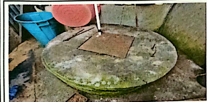
Foto 3: SUSTITUCIÓN DE SISTEMA DE AGUA POTABLE CON BOMBA SUMERGIBLE 1 HP. TOTAL 1 SISTEMA
