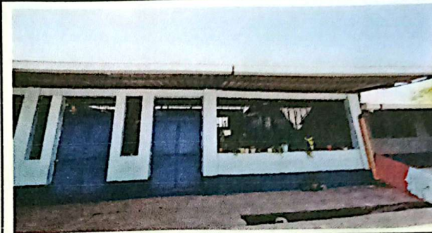
Foto 2: SUSTITUCIÓN DE CANAL DE METAL. TOTAL 91 METROS LINEALES
