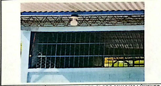
Foto 6: SUSTITUCIÓN DE BOMBILLO LED GLOBO 30W 2400 LÚMENES. TOTAL 26 BOMBILLO
