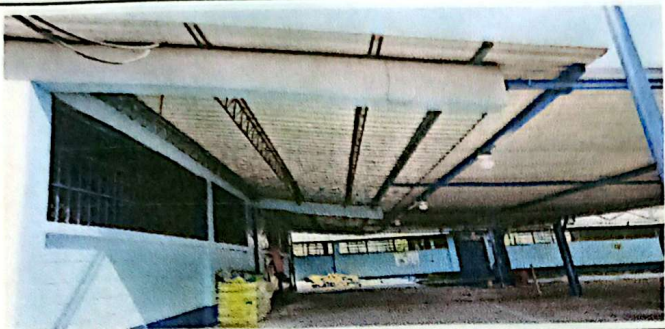
Foto 7: SUSTITUCIÓN DE PLAFONERAS. TOTAL 26 PLAFONERAS
