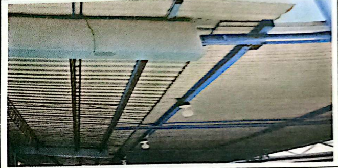
Foto 10: SUMINISTRO E INSTALACION DE CABLEADO ELECTRICO CALIBRE 12 AWG VIAKON. TOTAL 185 METROS LINEALES
