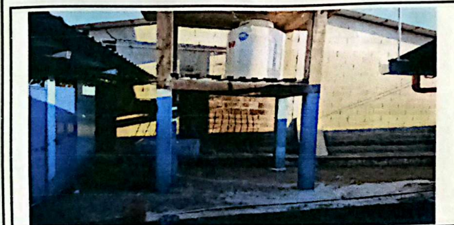
Foto 5: REPARACION DE BASE DE DEPOSITO DE AGUA CON ESTRUCTURA METALICA 1.50X3.30 METROS. TOTAL 1 BASE DE DEPOSITO
