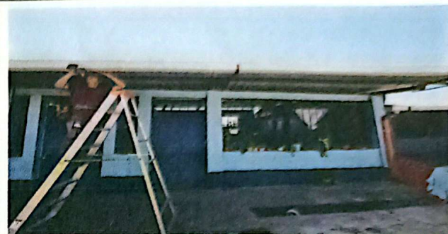
Foto 2: SUSTITUCIÓN DE CANAL DE METAL. TOTAL 91 METROS LINEALES
