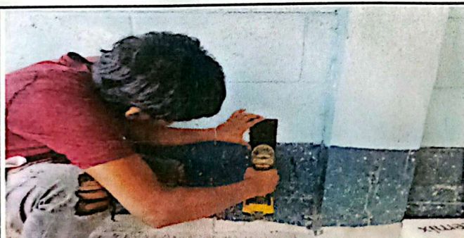
Foto 9: SUSTITUCIÓN DE TOMACORRIENTES DOBLES POLARIZADO 15A EAGLE. TOTAL 15 TOMACORRIENTES
