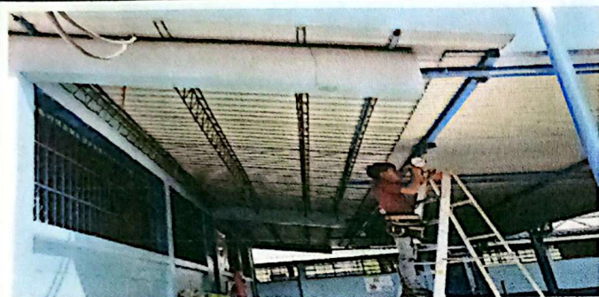
Foto 7: SUSTITUCIÓN DE PLAFONERAS. TOTAL 26 PLAFONERAS
