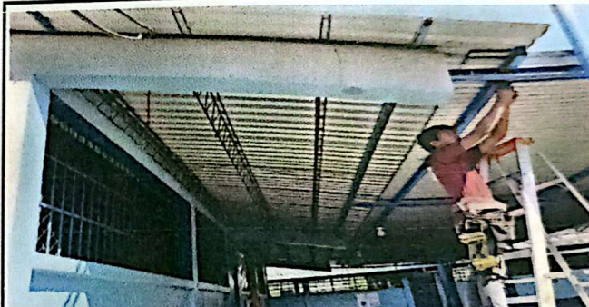
Foto 10: SUMINISTRO E INSTALACION DE CABLEADO ELECTRICO CALIBRE 12 AWG VIAKON. TOTAL 185 METROS LINEALES
