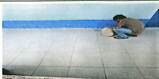
Foto 1: SUSTITUCION DE PISO CERAMICO. TOTAL 146 METROS CUADRADOS
