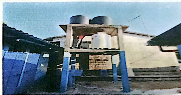
Foto 4: SUSTITUCIÓN DE DEPÓSITO DE AGUA 1100 LTS. TOTAL 1 DEPÓSITO
