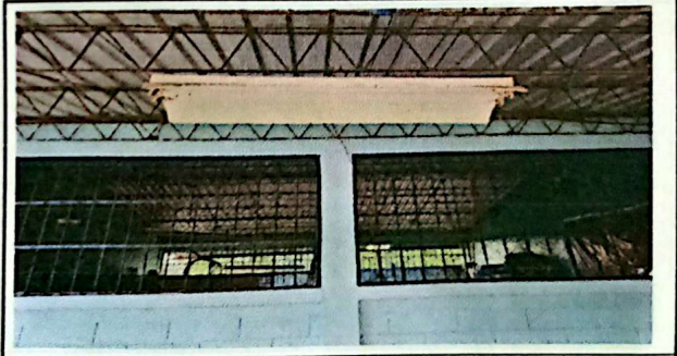
Foto 6: SUSTITUCIÓN DE BOMBILLO LED GLOBO 30W 2400 LÚMENES. TOTAL 26 BOMBILLOS
