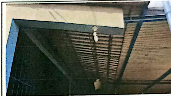
Foto 10: SUMINISTRO E INSTALACION DE CABLEADO ELECTRICO CALIBRE 12 AWG VIAKON. TOTAL 185 METROS LINEALES
