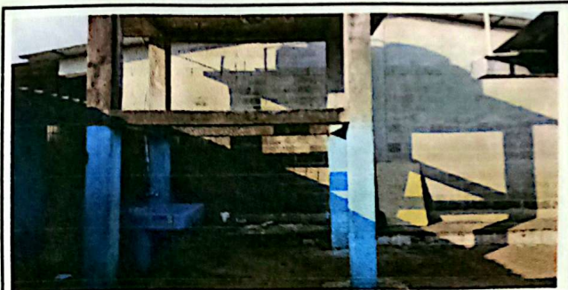
Foto 5: REPARACION DE BASE DE DEPOSITO DE AGUA CON ESTRUCTURA METALICA 1.50X3.30 METROS.TOTAL 1 BASE DE DEPÓSITO
