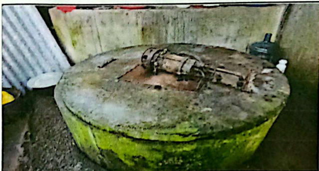
Foto 3: SUSTITUCIÓN DE SISTEMA DE AGUA POTABLE CON BOMBA SUMERGIBLE 1 HP. TOTAL 1 SISTEMA
