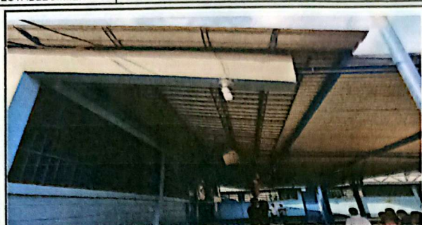
Foto 7: SUSTITUCIÓN DE PLAFONERAS. TOTAL 26 PLAFONERAS
