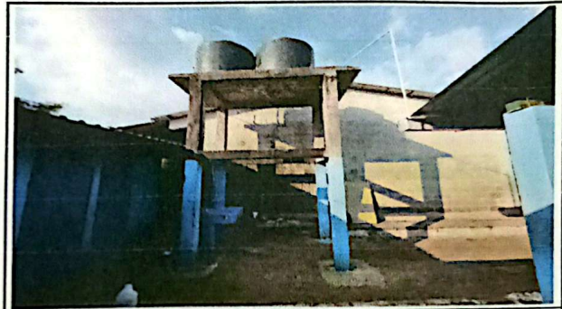
Foto 4: SUSTITUCIÓN DE DEPÓSITOS DE AGUA 1100 LTS TOTAL 1 DEPÓSITO
