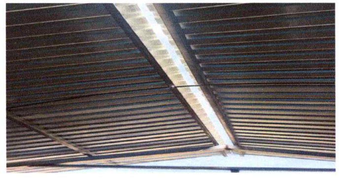
FOTO 2 SUSTITUCION DE ESTRUCTURA DE MADERA POR METAL GALVANIZADO CALIBRE 16
