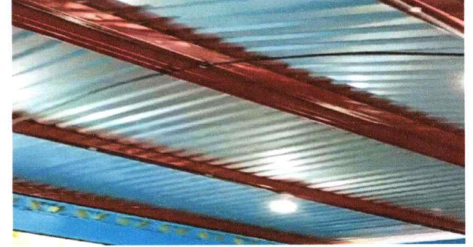
FOTO 4 SUSTITUCION DE CABLEADO ELECTRICO CALIBRE 12 AWG CONDUMEX
