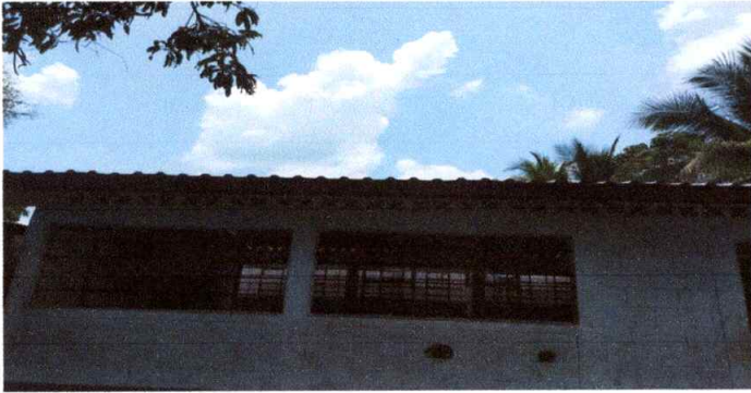
FOTO 1 SUSTITUCION DE CUBIERTA DE LAMINA ACANALADA POR LAMINA TROQUELADA ALUZINC CALIBRE 26
