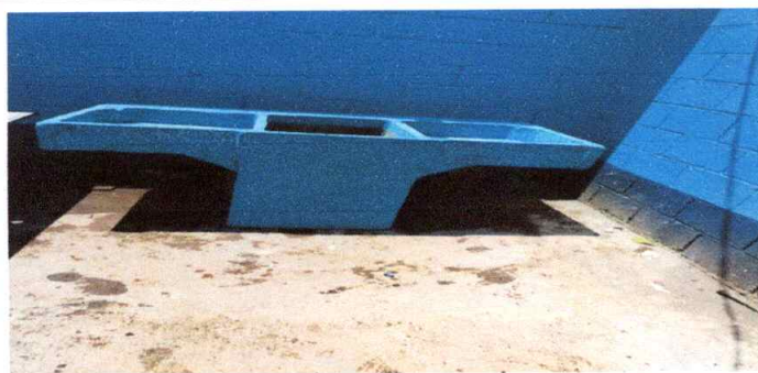
FOTO 5 SUSTITUCION DE PILA PLASTICA DE DOS LAVADEROS
