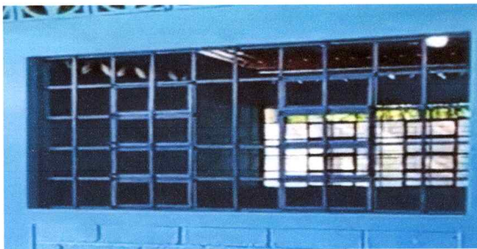
FOTO 3 MANTENIMIENTO DE ESTRUCTURA DE SOPORTE DE METAL ANTICORROSIVO
