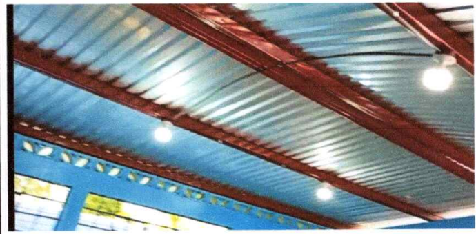
FOTO 6 SUSTITUCIÓN DE FOCO LED GLOBO 30W SYLVANIA
