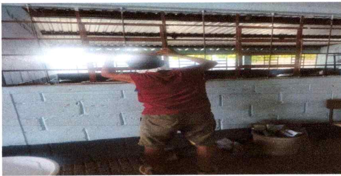
FOTO 3 MANTEIMIENTO DE ESTRUCTURA DE SOPORTE DE METAL ANTICORROSIVO
