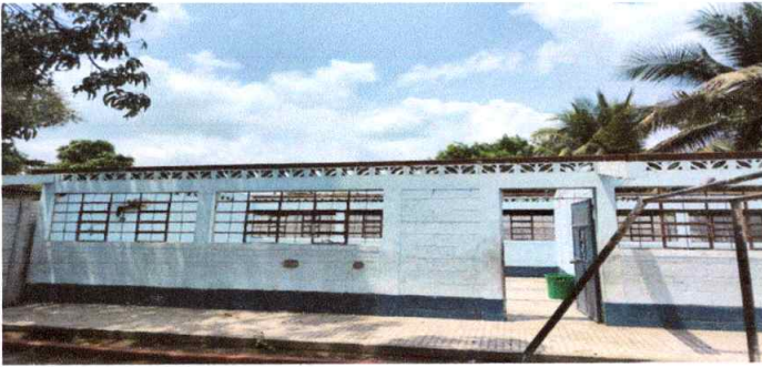
FOTO 1 MANTEIMIENTO DE ESTRUCTURA DE SOPORTE DE METAL ANTICORROSIVO
