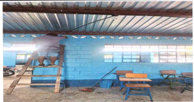
FOTO 6 SUSTITUCIÓN DE FOCO LED GLOBO 30W SYLVANIA
