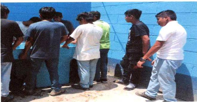
FOTO 5 SUSTITUCION DE PILA PLASTICA DE DOS LAVADEROS
